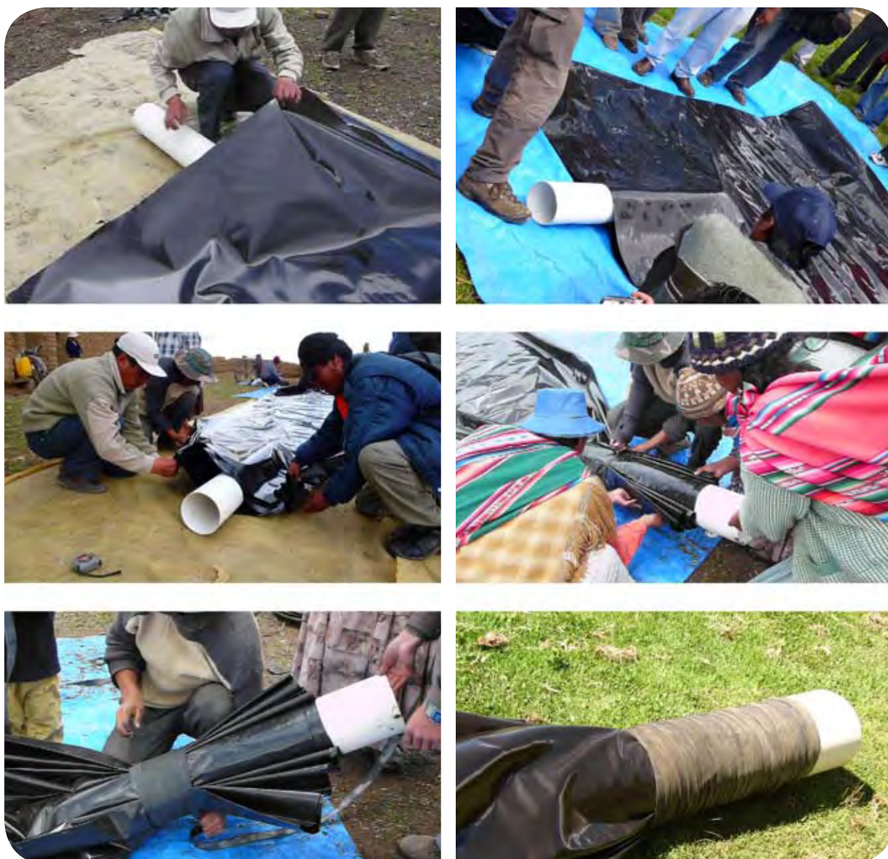
Figura 18: Para amarrar los tubos de entrada y salida al biodigestor, hay que colocarlos centrados, recoger el plástico lateral haciendo pliegues en forma de acordeón, y comenzar a amarrar con liga de neumático.
