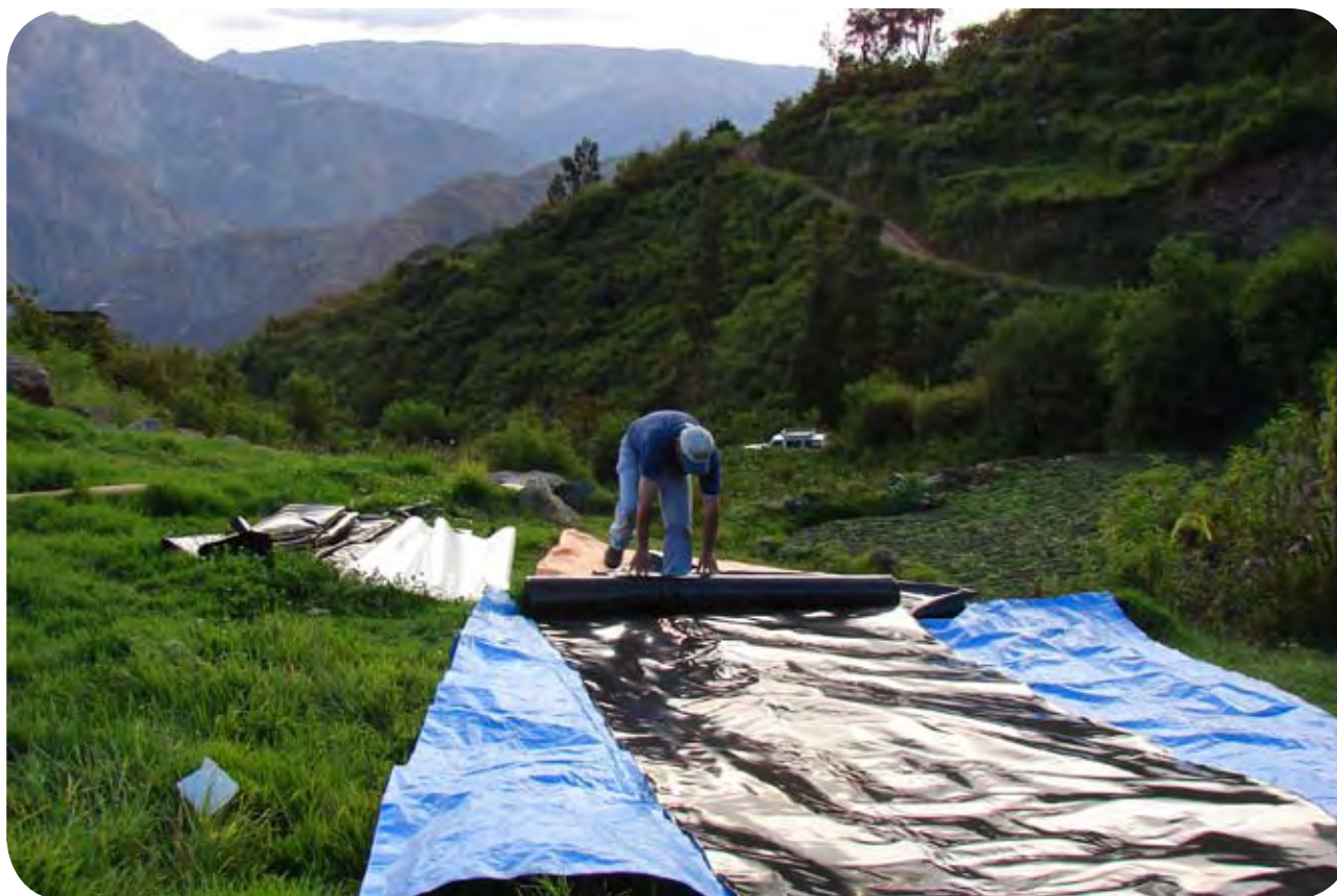
Figura 10: Desenrollando el rollo de polietileno tubular. Un rollo de polietileno tubular suele ser de 50 metros, y el ancho del rollo (que es la mitad de la circunferencia de la manga) es variable según lo que se compre.
