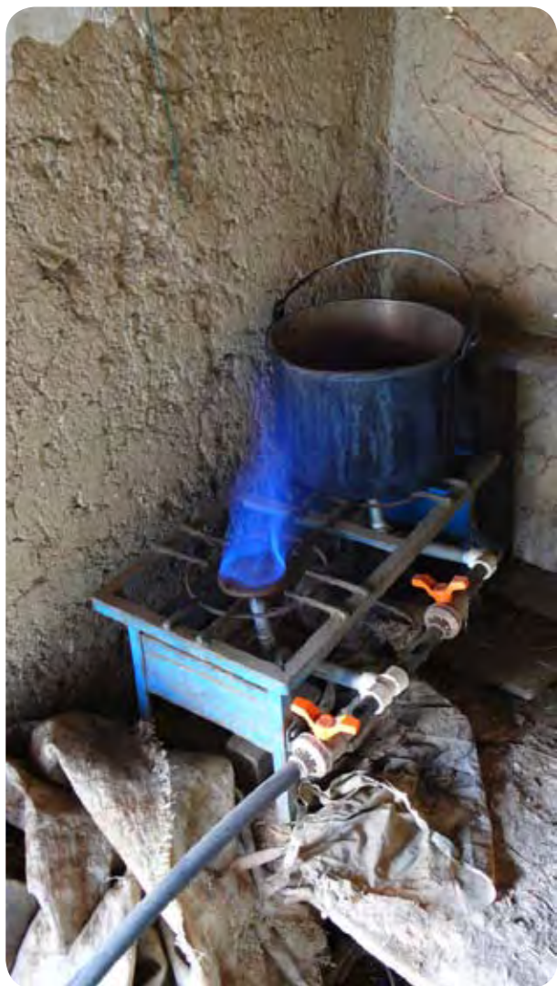
Figura 2: Cocina metálica adaptada para funcionar con biogás.
