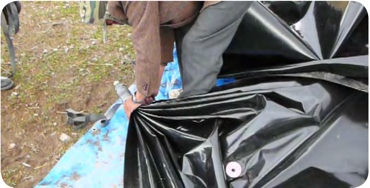
Figura 30: Se amarran los lados sellados, plegándolos en forma de acordeón, contra un objeto hueco, para poder pasar una pita por el hueco y así colgar el biodigestor del techo.
