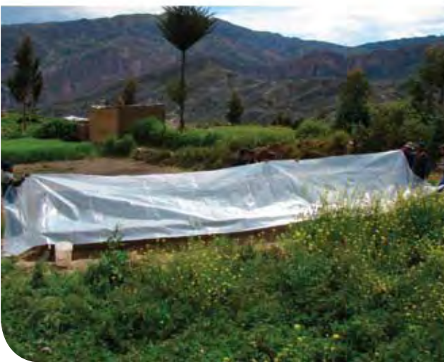
Figura 25: En el caso de altiplano hay que poner la carpa solar. Primero se ponen unos palos enterrados en los tapiales, sobre ellos se echa una capa de barro fresco, encima la carpa y de nuevo barro fresco.
